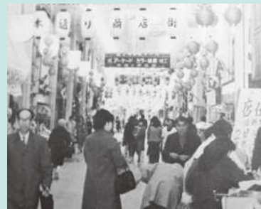
アーケードカラー舗装竣工
